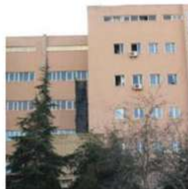
Ospedali Riuniti, Reggio C. (Italia) Riuniti Hospital in Reggio Calabria (Italy)
