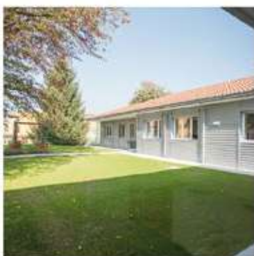
Centro l'Aurora, Gozzano (Italia) L'Aurora Centre, Gozzano (Italy)
